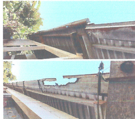
Foto 4: CANALES Y BAJAS DE AGUA PLUVIAL
