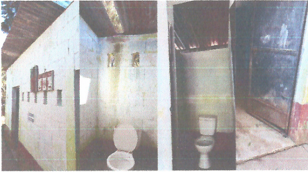
Foto 1: REMOZAMIENTO DE SERVICIOS SANITARIOS
